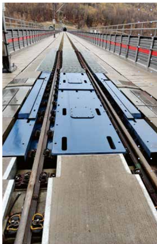
Die Filstalbrücke auf der Neubaustrecke Wendlingen – Ulm
