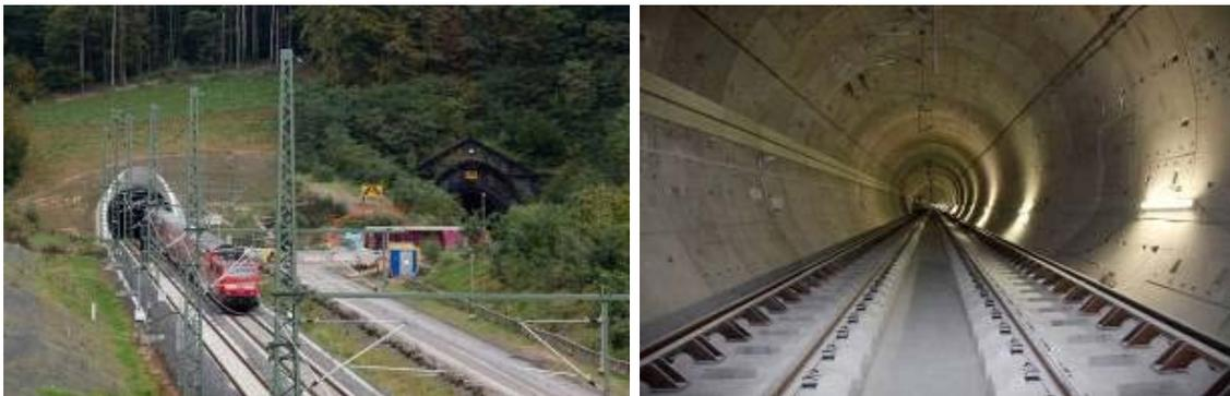
Abbildung 20 + 21: Südportal neuer und alter Schlüchterner Tunnel sowie Innenschale des neuen Schlüchterner Tunnel
