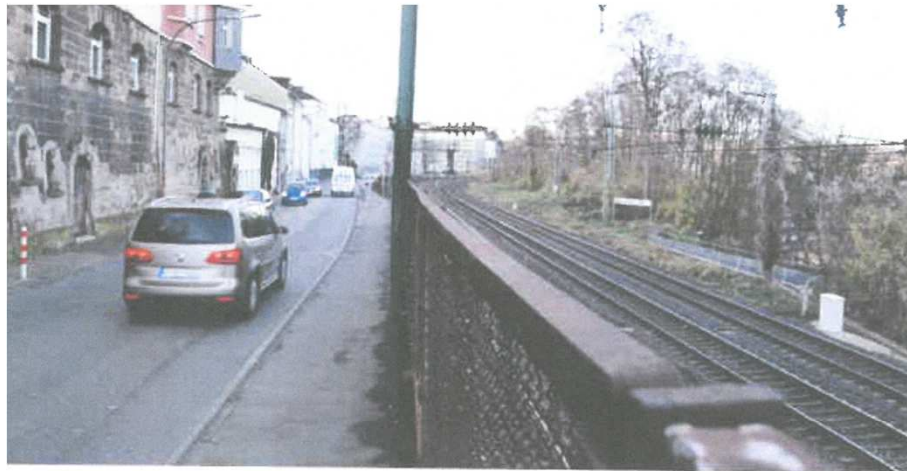
Abb. 1 Gehweg parallel zum Gleis in Höhe Standort Esig 86GG
