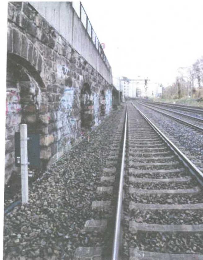
Abb. 2 Stützmauer am Standort Esig 86GG in km 38,860
